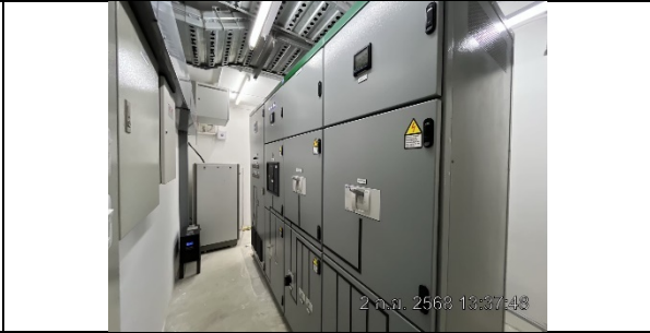
รูปที่ ผ7.40 สวิตช์บอร์ดแรงสูง
