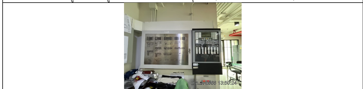
รูปที่ ๗7.51 แผงควบคุม (Fire alarm control panel : FCP)
