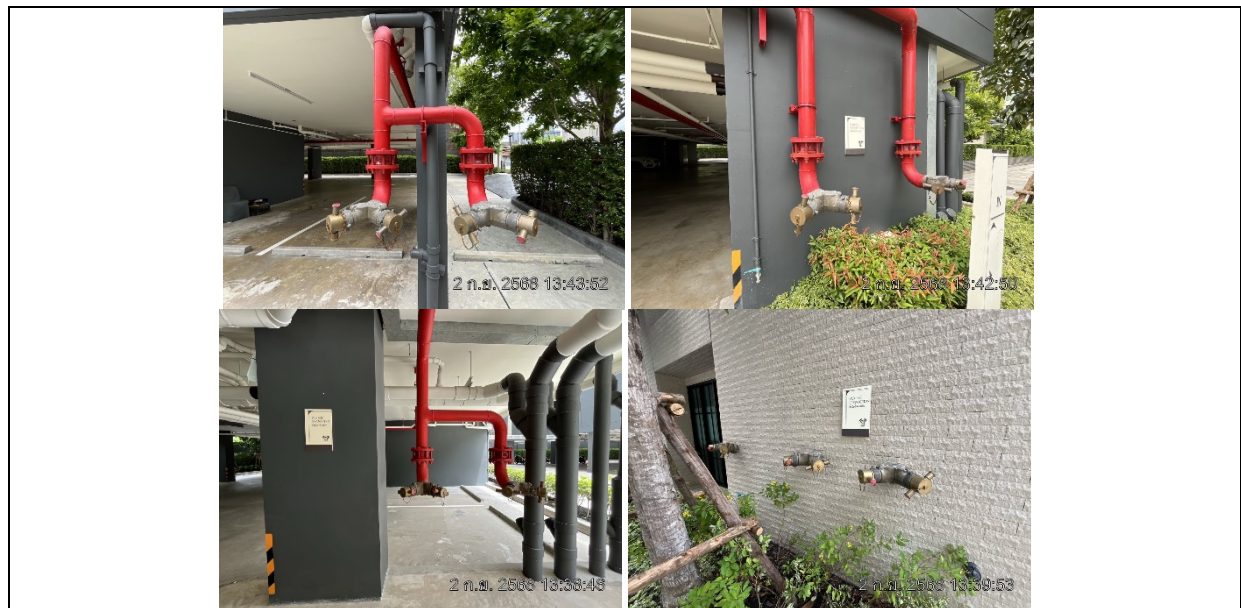
รูปที่ ๗7.49 หัวรับน้ำดับเพลิงภายนอกอาคาร อาคาร A, B, C และ D
