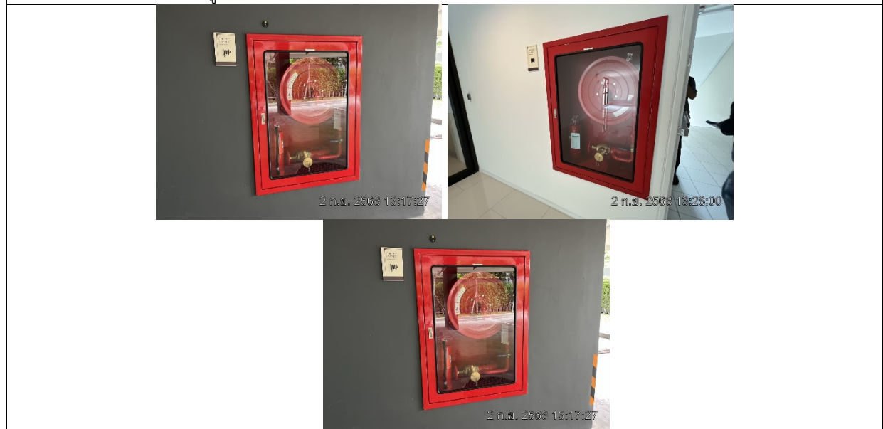
รูปที่ ๗7.50 ตู้เก็บสายฉีดน้ำดับเพลิงพร้อมอุปกรณ์ (Fire hose cabinet : FHC)
